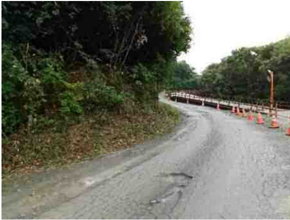
写真-2 拡幅箇所の状況（現状）
