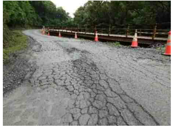
写真-3 舗装面の状況（現状）
