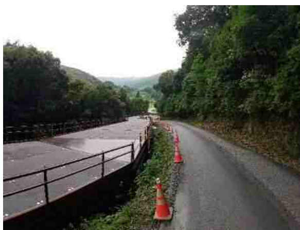
写真-1 通行路の設置状況
